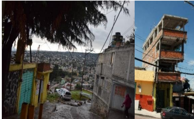
Figura. 3.3.24 Construcciones de más de 2 pisos ubicados en pendientes muy pronunciadas en San Juan Tepenahuac y La Magdalena Petlacalco.
