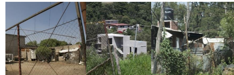
Figura. 3.3.22. Viviendas ubicadas en zonas propensas a sufrir deslaves en San Miguel Topilejo y San Pedro Atocpan.
