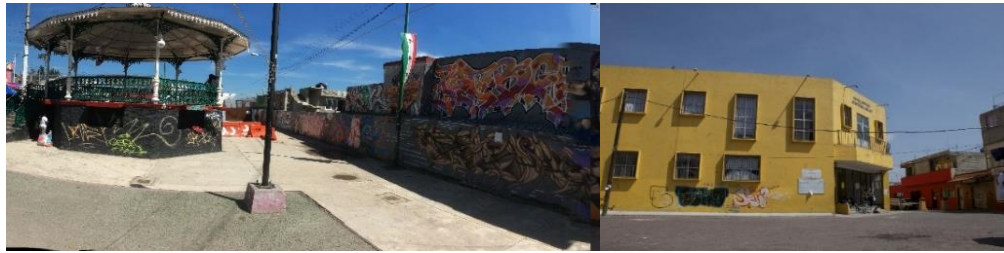
Figura. 3.3.26 Equipamiento urbano con presencia de grafitis en San Miguel Topilejo y San Andrés Mixquic
