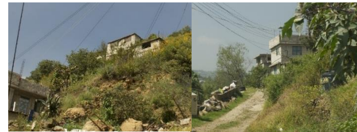
Figura. 3.3.21. Estructuras frágiles ante la presencia de fenómenos naturales, ubicadas en Santo Tomas Ajustco, La Magdalena Petlacalco y San Lorenzo Acopilco
