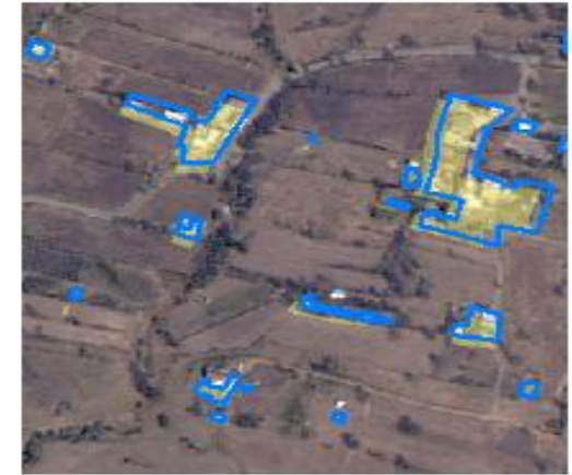
Asentamiento Atlaxohacaya ubicado en Milpa Alta, presenta desplazamiento.
