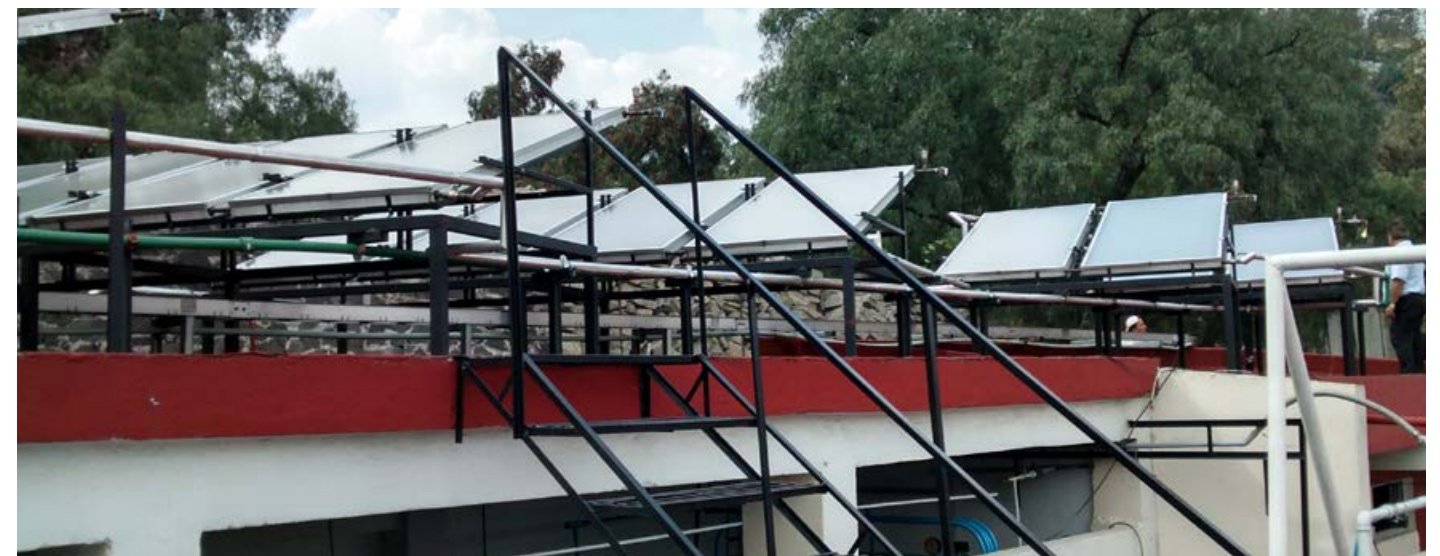
Instalación de calentadores solares de agua en hospitales de la CDMX.
