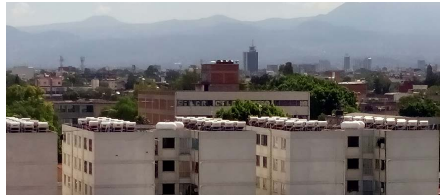
Calentadores solares de agua en casas habitación.
