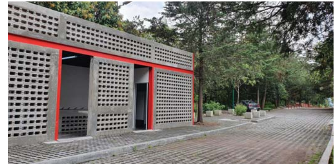
Módulo de baños
