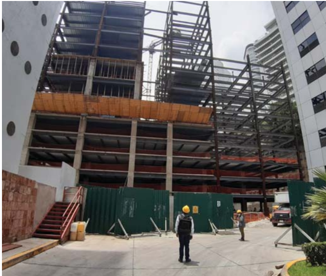
Inspección en obras
