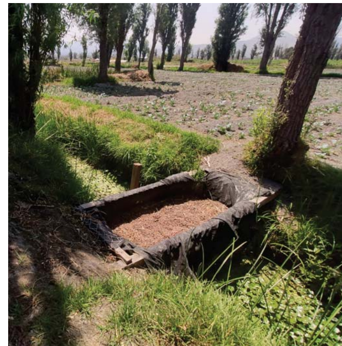
Biofiltros zona chinampera Mixquic
