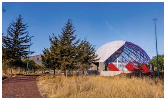
Camino parque Carpa Geodesica
