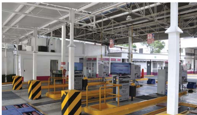
Centro de Verificación
