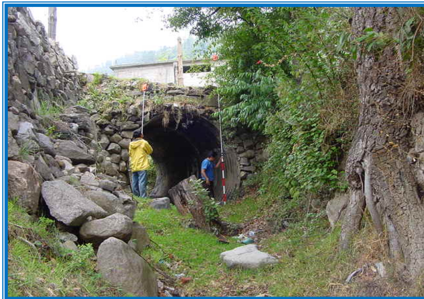
Levantamiento topográfico de un cruce para el acceso de un predio.
