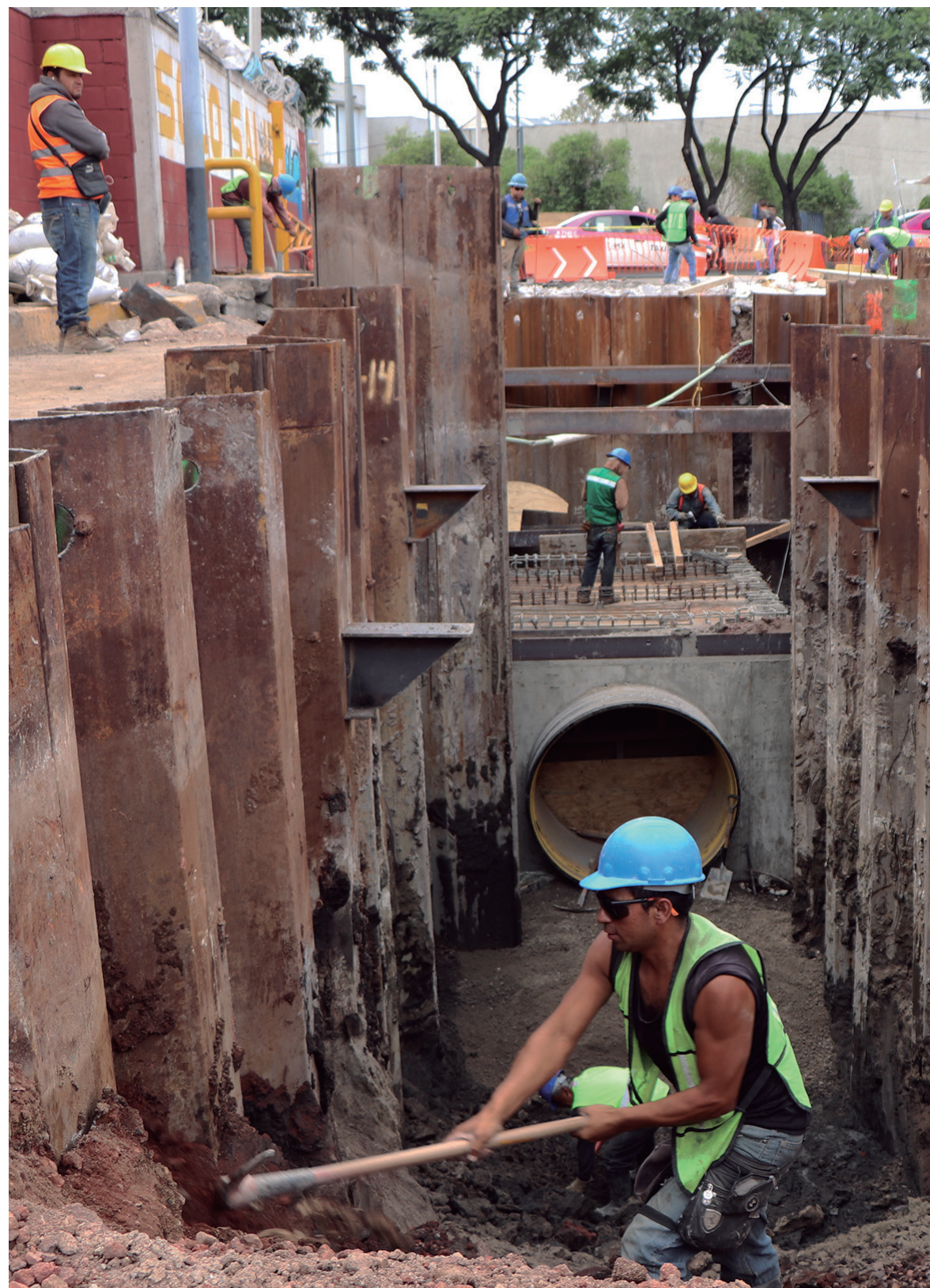
Rehabilitación de drenaje
