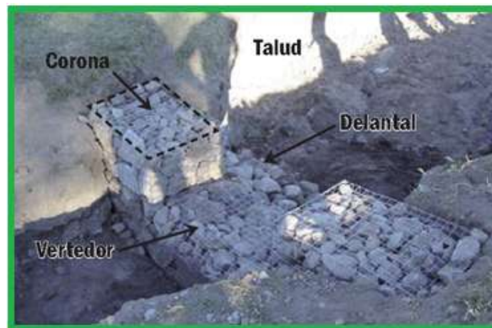
Fig. 27. Presa de malla ciclónica esquematizada.
