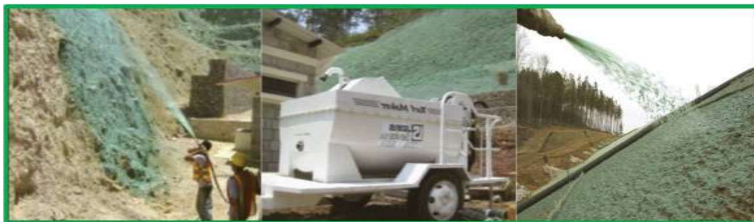
Fig. 35. Imágenes del proceso de hidrosiembra.
