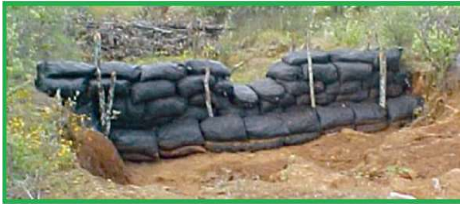
Fig. 25. Imagen de una presa de geocostal.
