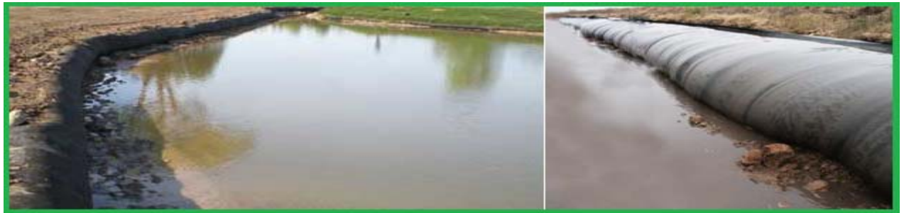
Fig. 9. Uso de geotubos para protección de los márgenes de un cauce.
