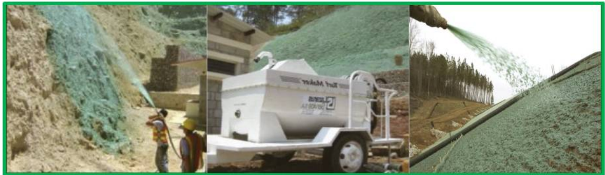
Fig. 33. Imágenes del proceso de hidrosiembra.
