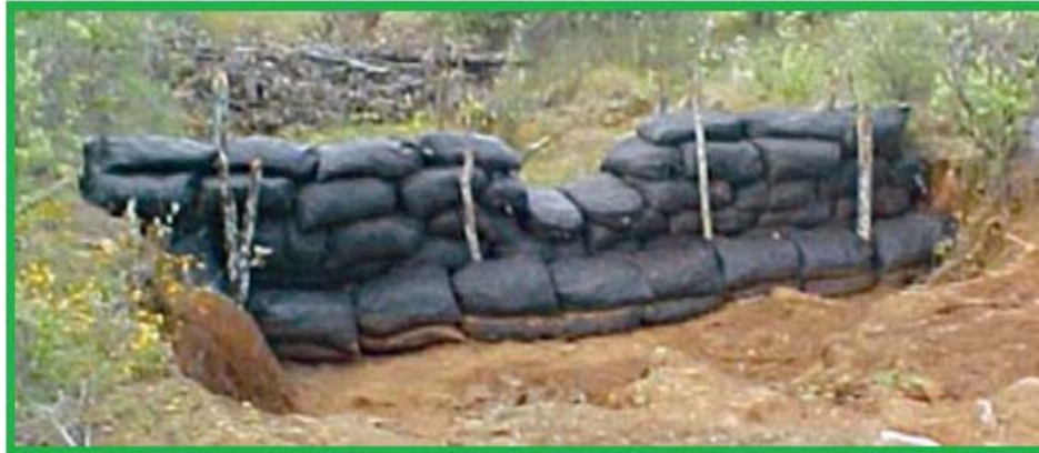
Fig. 23. Imagen de una presa de geocostal.
