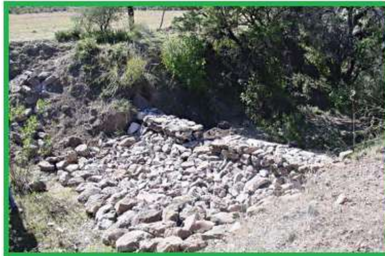
Fig.31. Imagen de unas presas de piedra.
