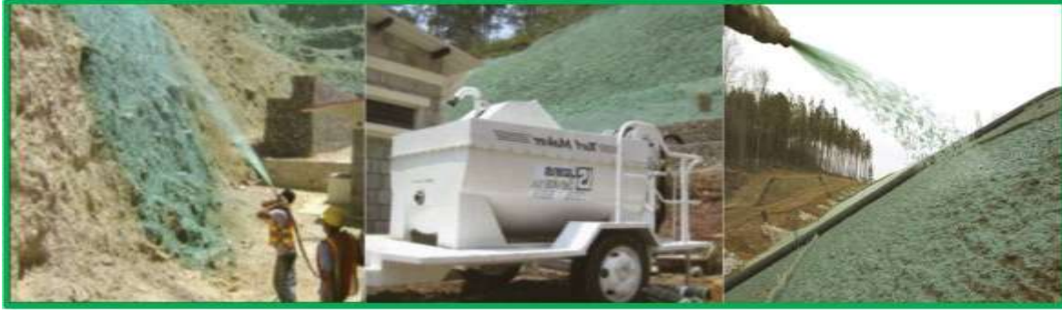
Fig. 38. Imágenes del proceso de hidrosiembra.
