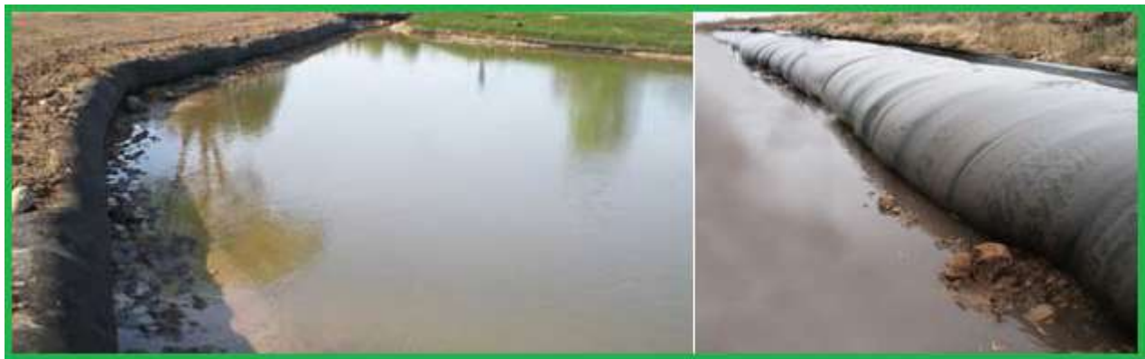
Fig. 13. Uso de geotubos para protección de los márgenes de un cauce.
