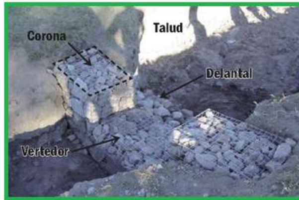
Fig. 30. Presa de malla ciclónica esquematizada.
