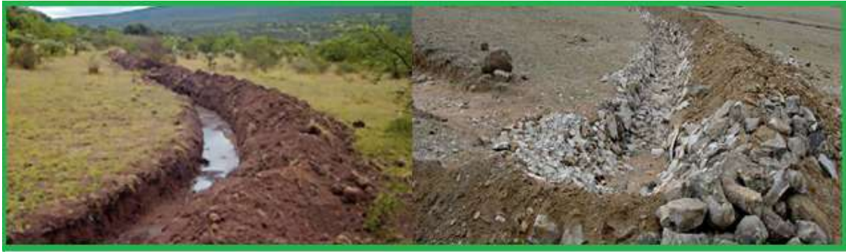
Fig. 10 Se ilustra una zanja de derivación recién excavada a la izquierda y una vez cabeceada para evitar arrastre de sedimentos a la derecha.
