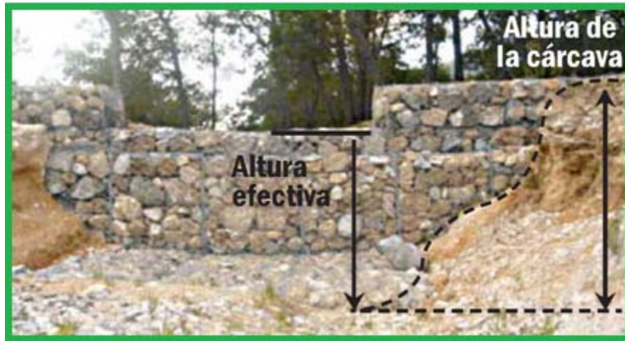
Fig. 32. Esquema de una presa de gavión.
