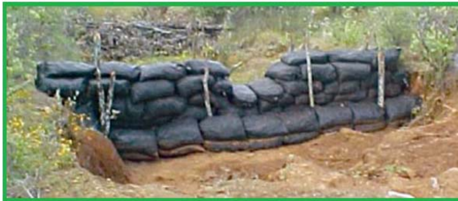
Fig. 27. Imagen de una presa de geocostal.
