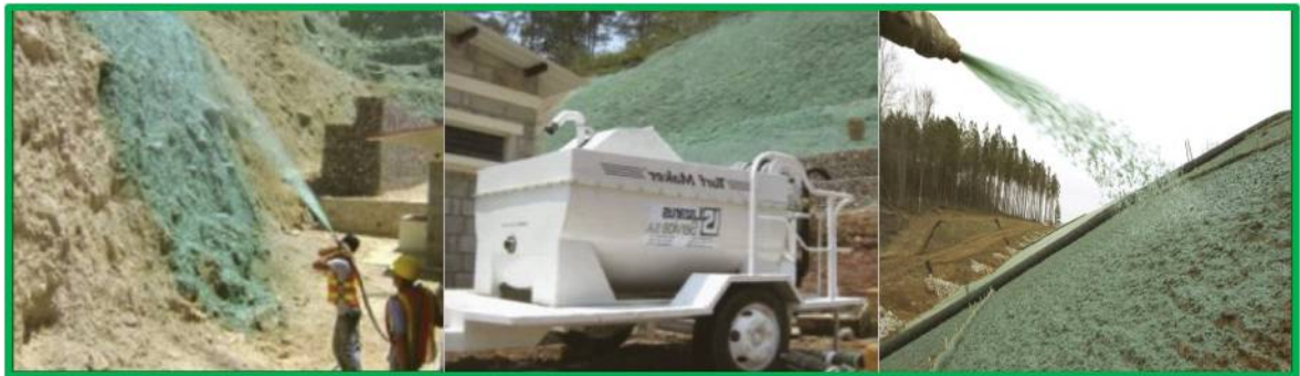
Fig. 37. Imágenes del proceso de hidrosiembra.
