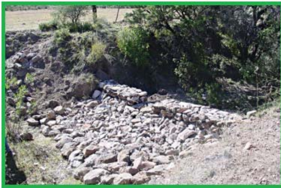
Fig.31 Imagen de unas presas de piedra.
