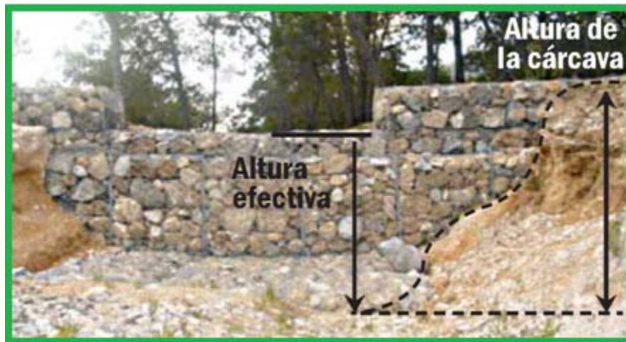
Fig. 32. Esquema de una presa de gavión.
