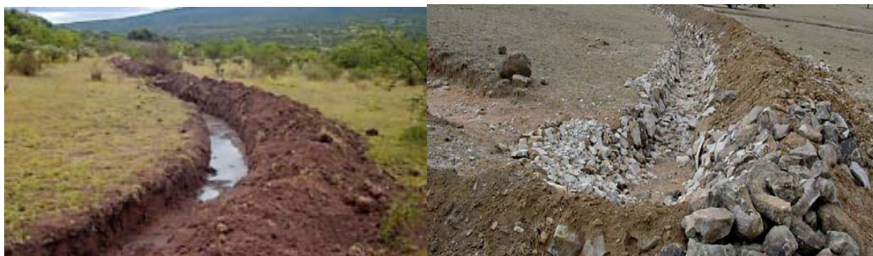
Fig. 10 Se ilustra una zanja de derivación recién excavada a la izquierda y una vez cabeceada para evitar arrastre de sedimentos a la derecha
