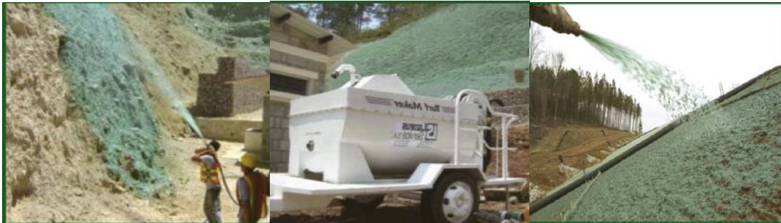
Fig. 37. Imágenes del proceso de hidrosiembra.
