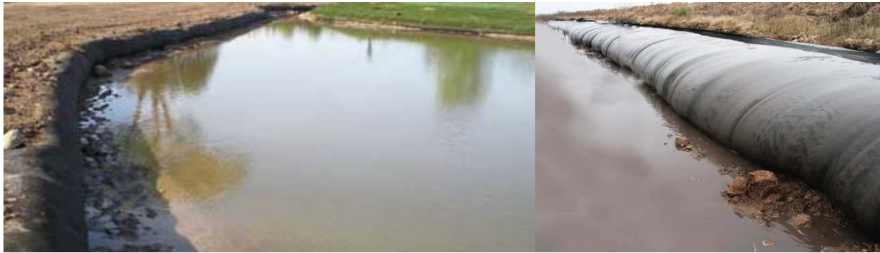
Fig. 12. Uso de geotubos para protección de los márgenes de cauca.
