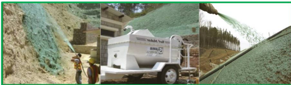
Fig. 36. Imágenes del proceso de hidrosiembra.
