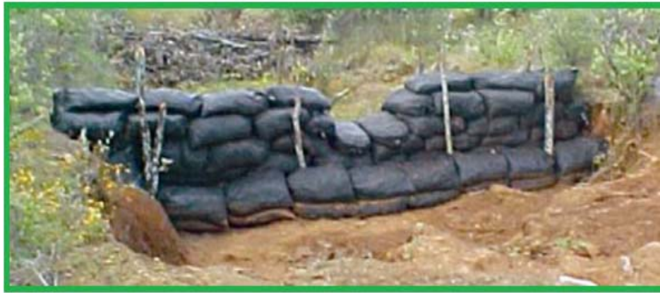
Fig. 26. Imagen de una presa de geocostal.
