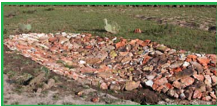
Fig. 8. Cabeceo de una cárcava.
