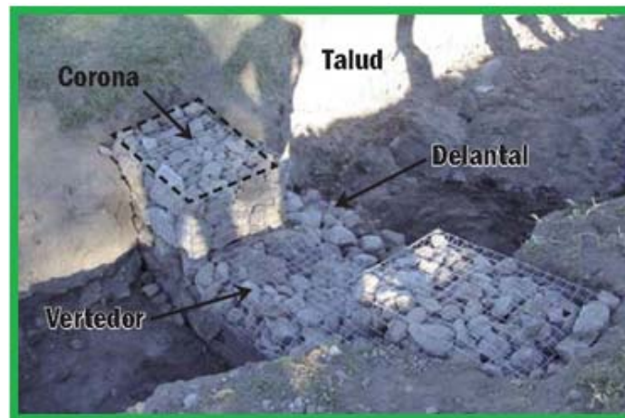
Fig. 28. Presa de malla ciclónica esquematizada.
