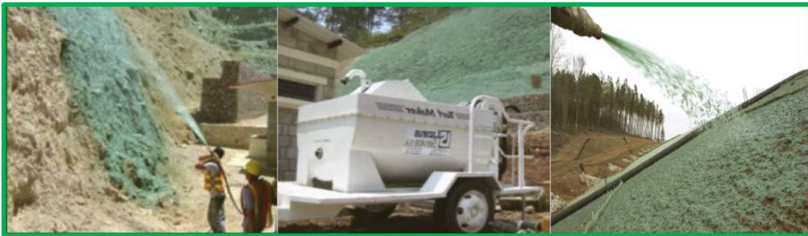
Fig. 36. Imágenes del proceso de hidrosiembra.
