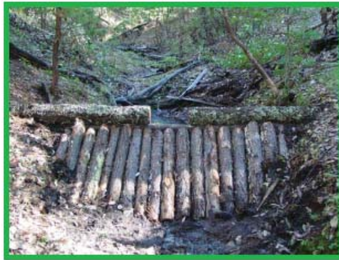
Fig. 29. Imagen de una presa de morillos.
