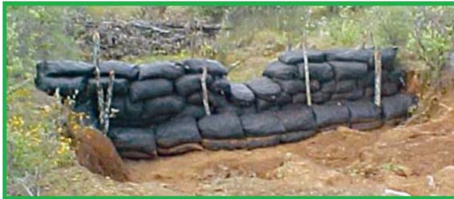
Fig. 26. Imagen de una presa de geocostal.
