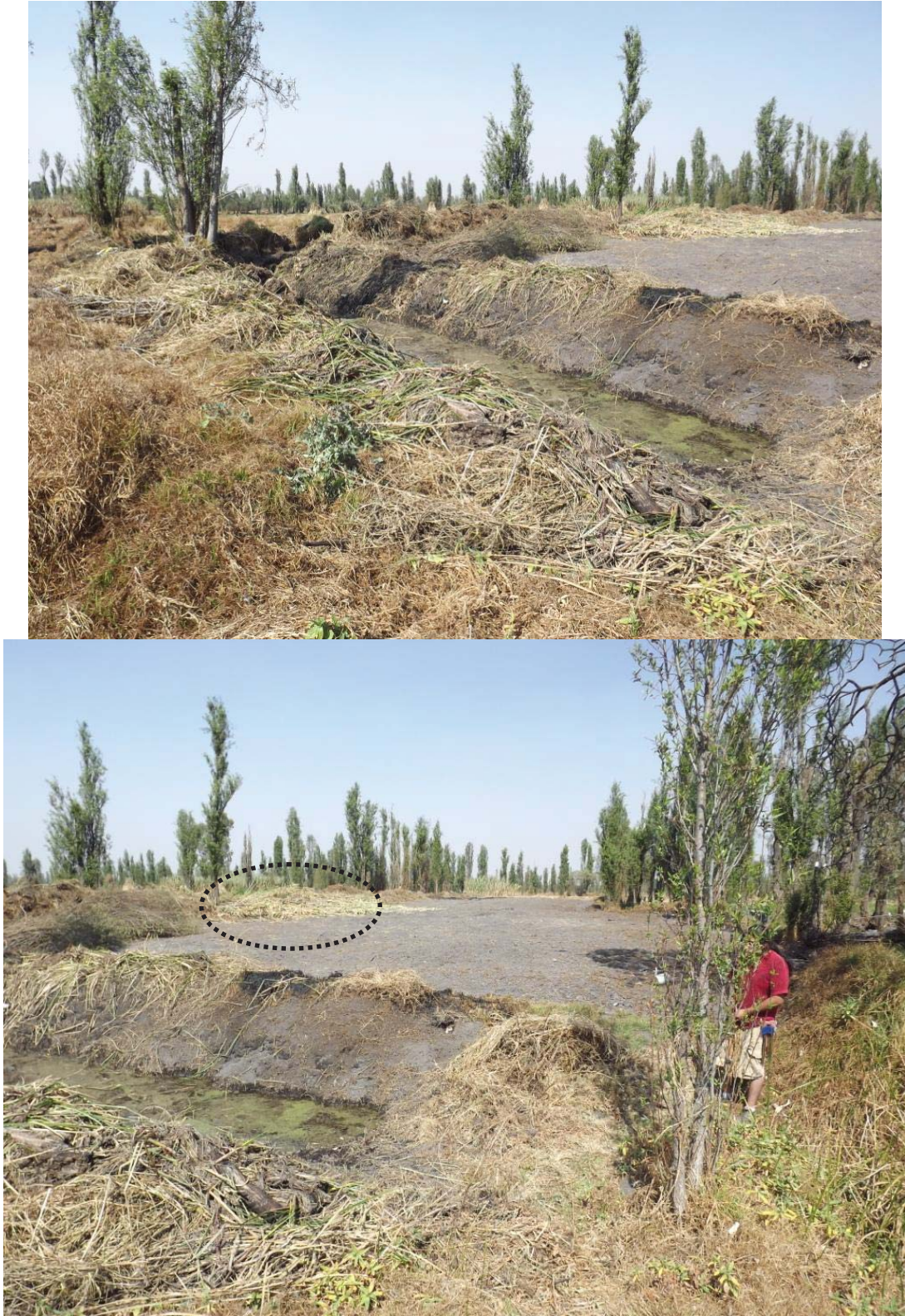
Figura 31. Inicio de apertura de zanja. En el círculo se señala el carrizal que se tumbó. Este extremo de la zanja es el punto B de salida con orientación sureste.
