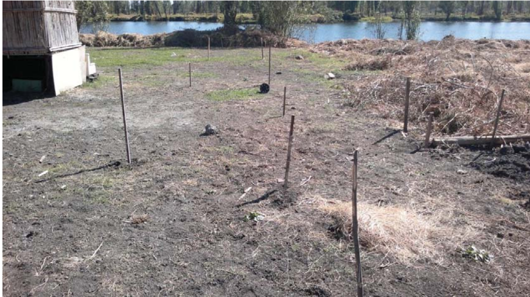
Figura 20. Trazado de inicio de la zanja Tezhuilo.
