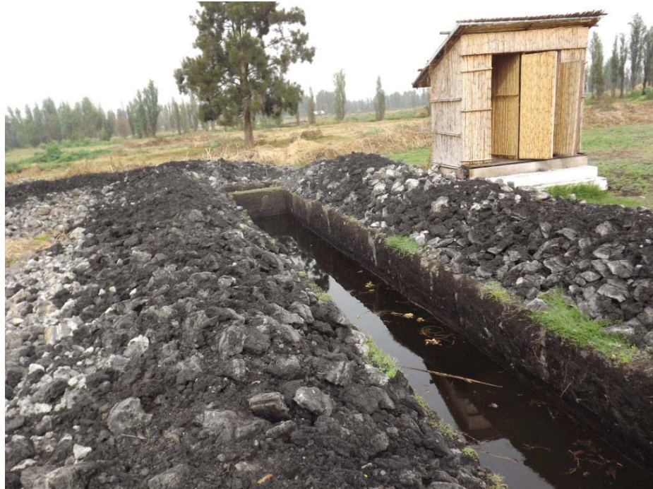
Figura 23. Zanja Tezhuilo terminada.
