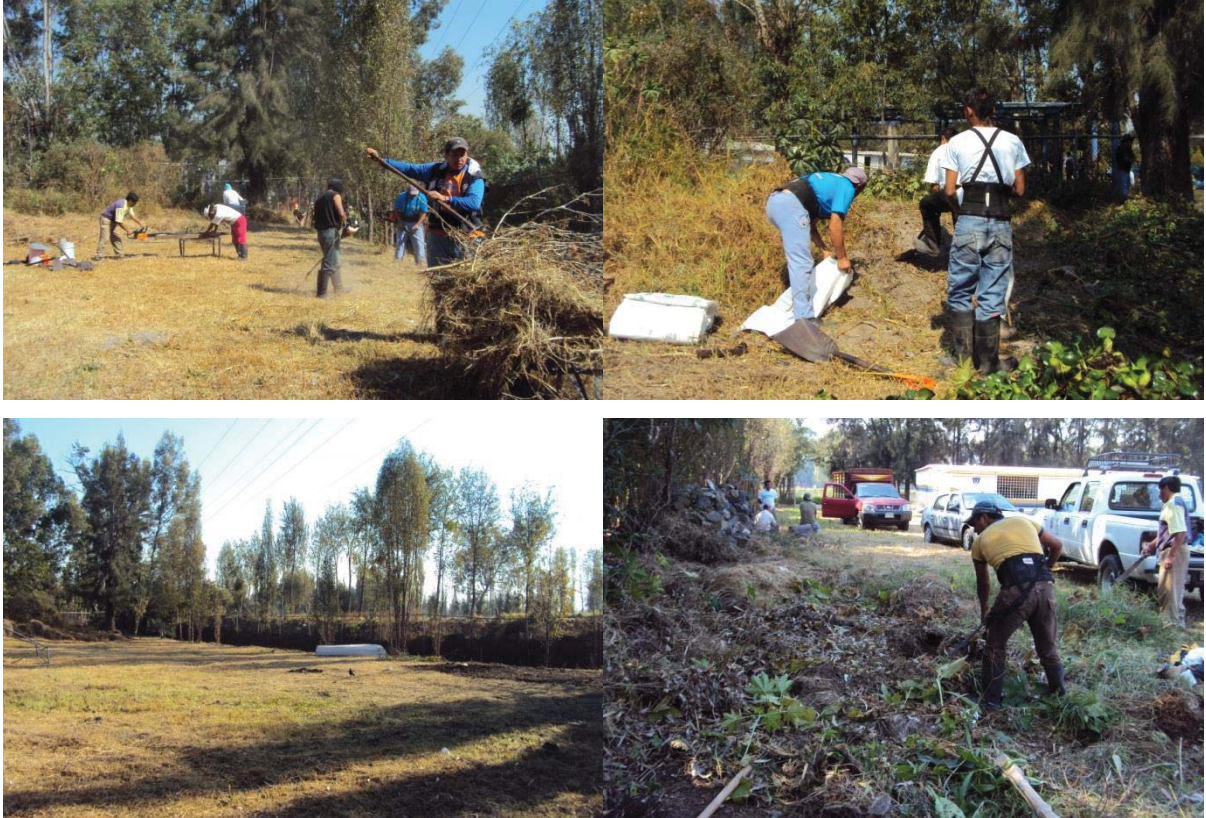
Figura 82. Segunda etapa. Trabajos finales de limpieza, deshierbe y nivelación del terreno.
