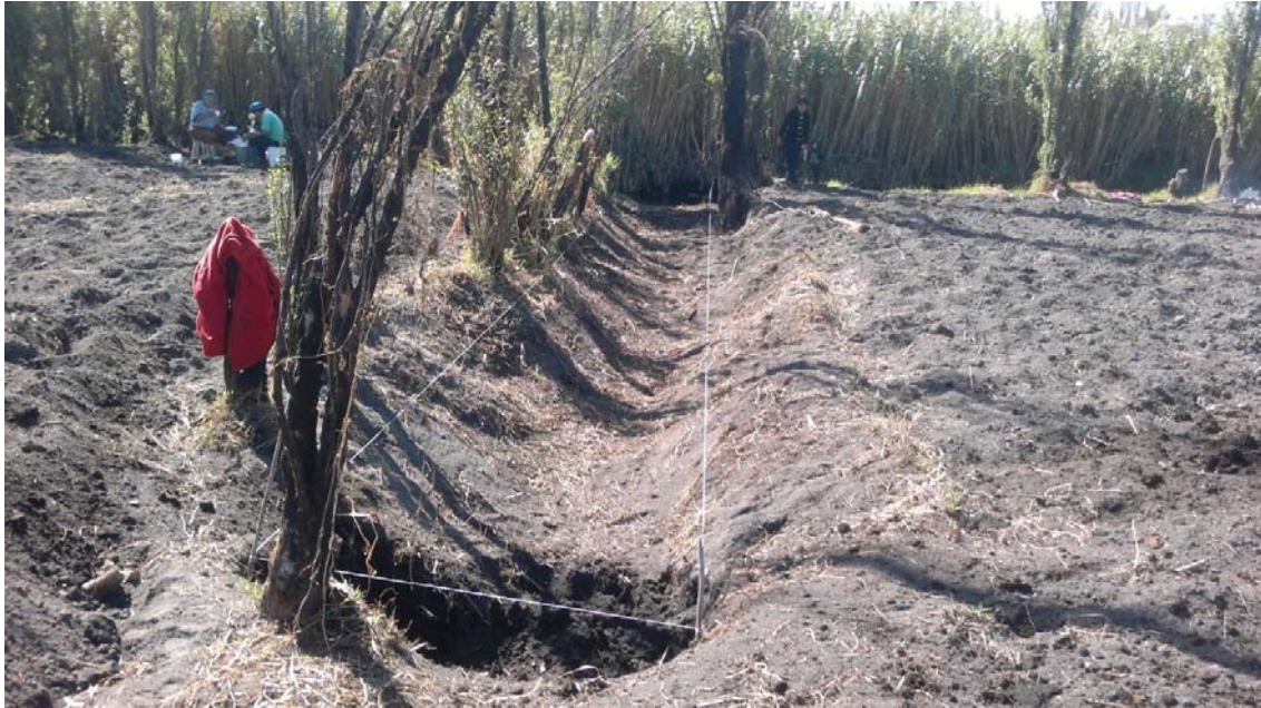
Figura 6. Vistas de la zanja chica, antes y después de la limpieza, y trazado de la zanja chica.
