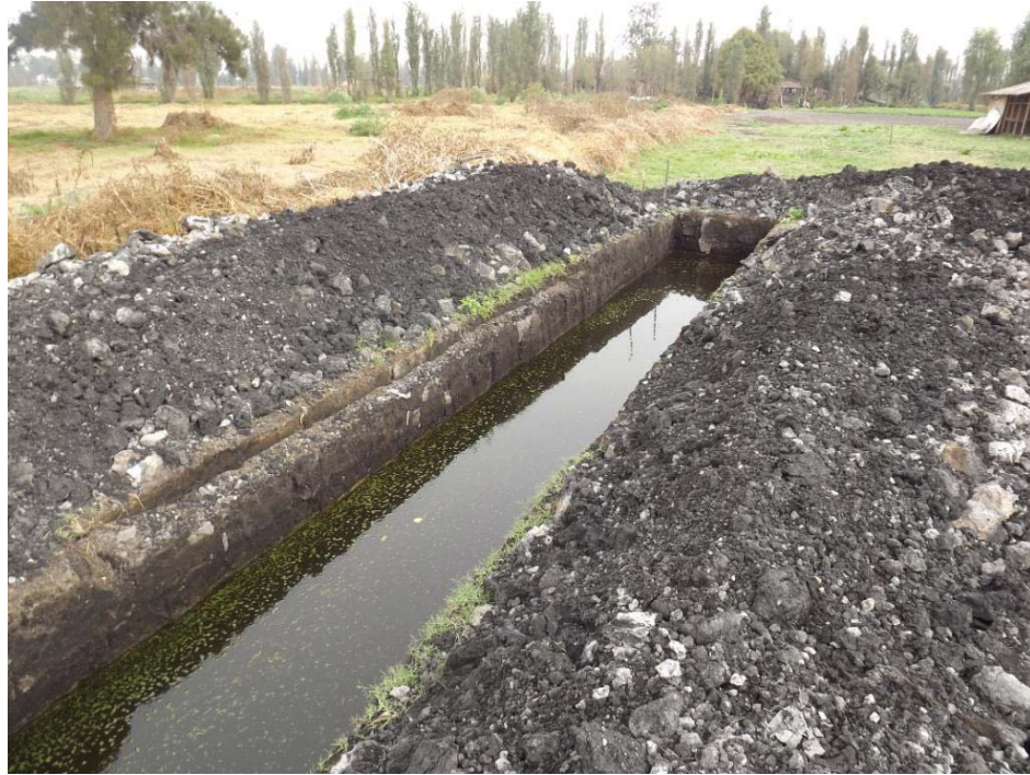
Figura 22. Zanja Ampampilco terminada.
