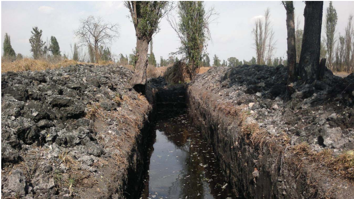
Figura 11. Zanja grande terminada.
