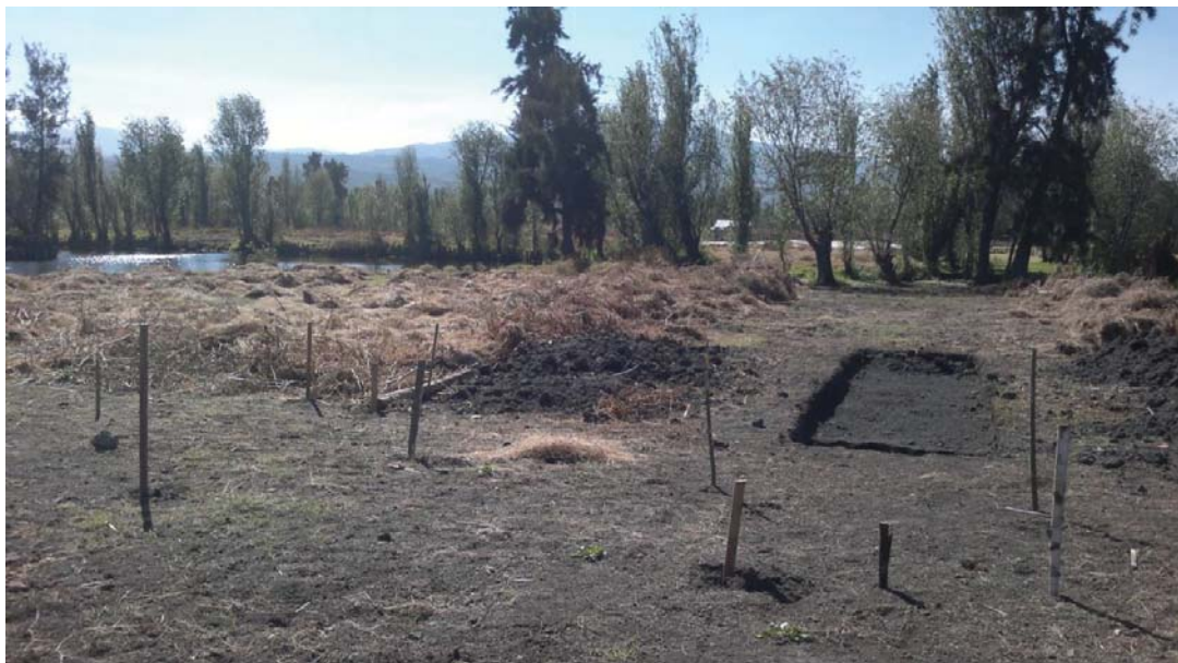
Figura 21. Vista del trazado de ambas zanjas.
