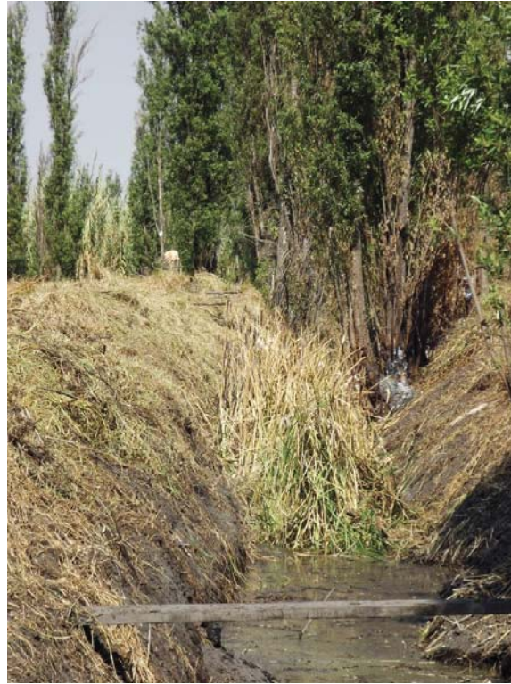
Figura 34. Aspecto del tular en medio de la zanja y retiro.
