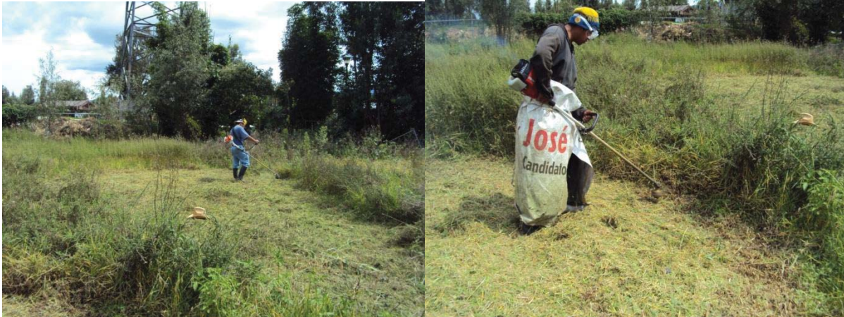
Figura 81. Primera etapa. Avance de la limpieza del terreno.
