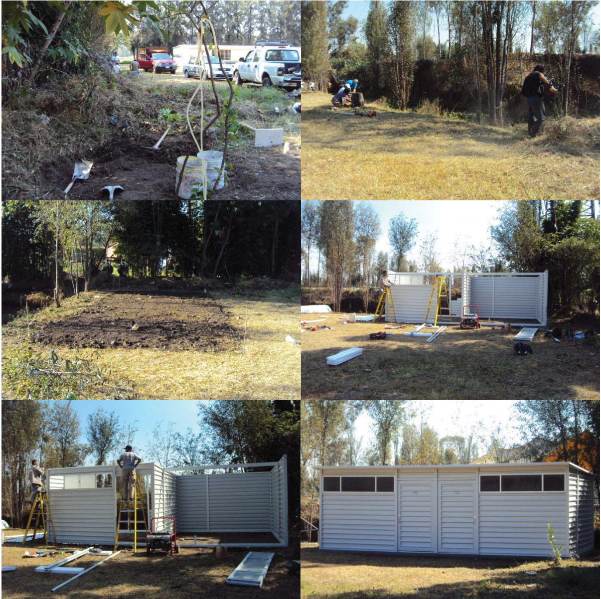
Figura 83. Trabajos de limpieza, desmonte, deshierbe, nivelación del terreno e instalación de la caseta desmontable.
