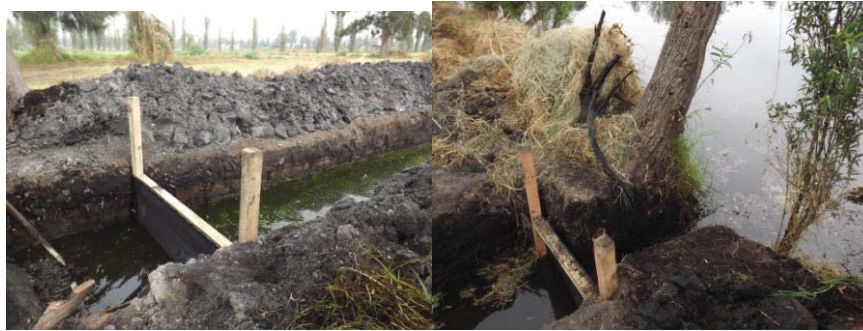
Figura 44. Compuertas de zanjas en la chinampa del Sr. Eduardo Rivera.
