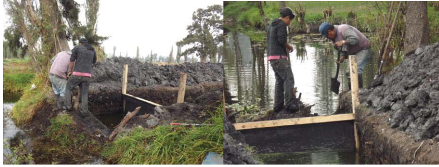
Figura 43. Colocación de compuertas en zanja y retiro de bordo en la chinampa del Sr. Eduardo Rivera.
