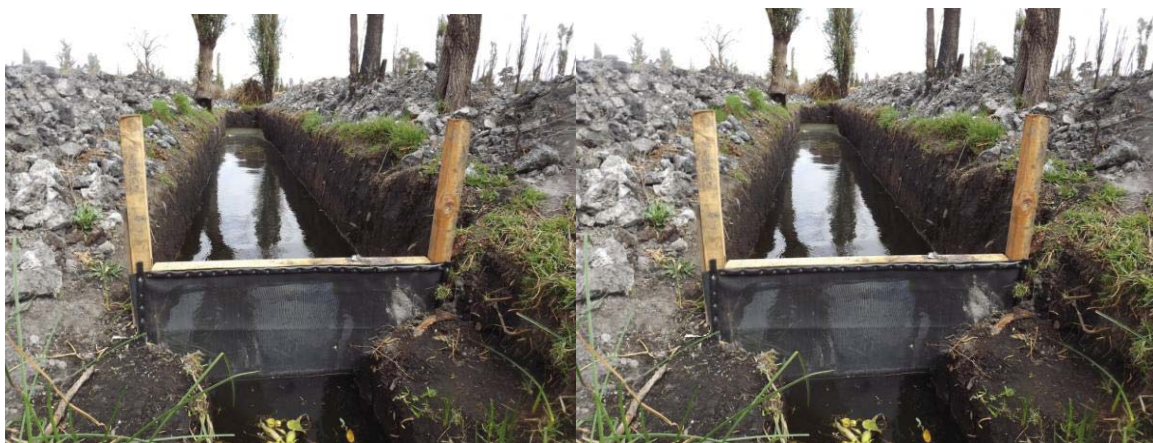
Figura 42. Compuertas terminadas en la zanja grande y en la zanja chica de la chinampa del Sr. Abertano.
