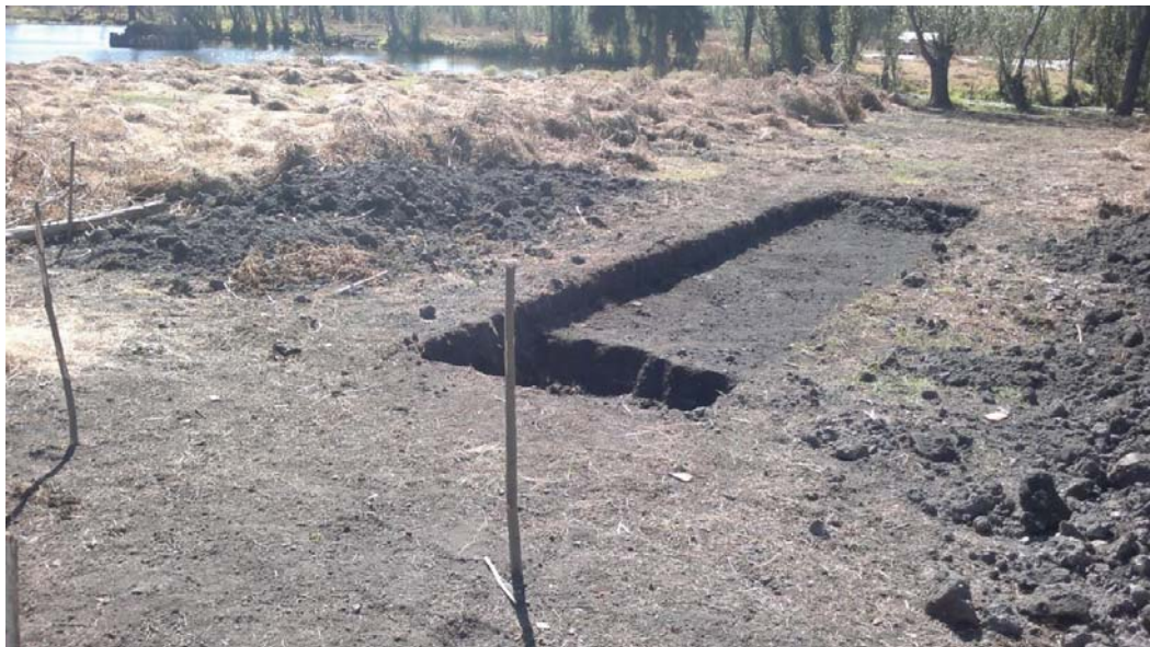
Figura 19. Trazado de inicio de la zanja Ampampilco.
