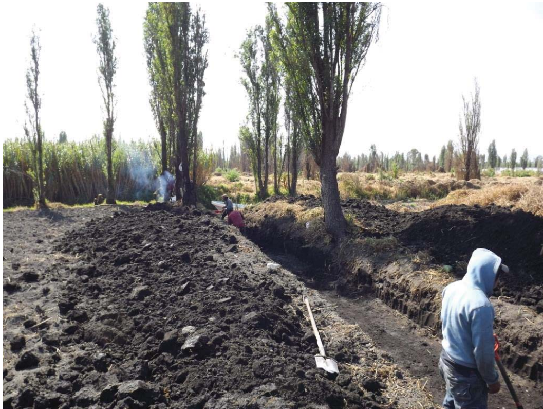
Figura 8. Inicio de apertura de la zanja grande
