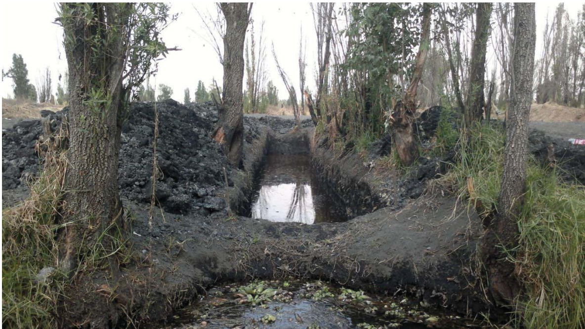
Figura 7. Zanja chica terminada.
