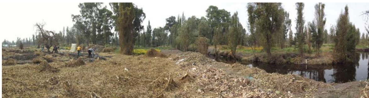
Figura 62. Limpieza y barbecho del terreno del Sr. Valentín, 9 de noviembre de 2011.
