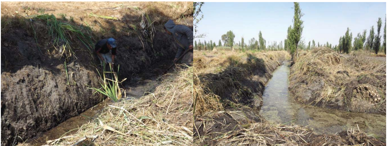
Figura 35. Vistas de la zanja en dirección norte.
