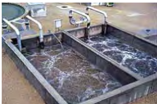
Sistemas de aireado de aguas residuales.
