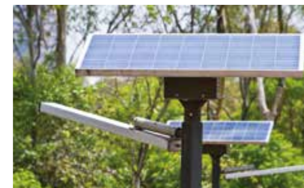
Luminaria solar, pista de corredores El Sope.
