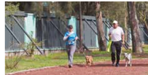
Rehabilitación de barda y malla perimetral.
