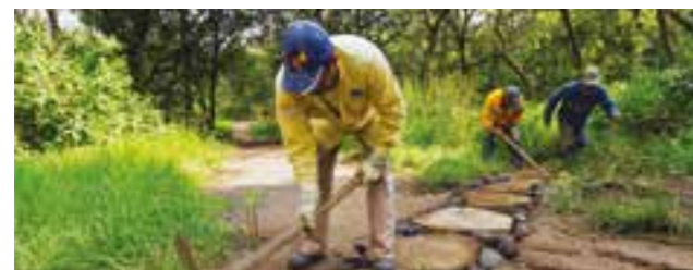
Trabajos de rehabilitación, Bosque de Tlalpan.
