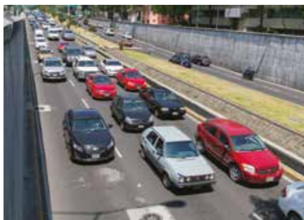
Viaducto Río Piedad, Ciudad de México.
