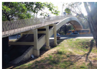
Los puentes ciclistas permiten la comunicación entre ambos lados de las barreras viales urbanas. Periférico, Ciudad de México
