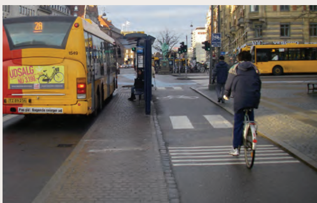
Las señales en el pavimento sobre los carriles ciclistas alertan a los ciclistas de las paradas de autobuses. Copenhague, Dinamarca
