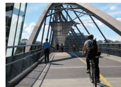
Puentes con tránsito compartido entre peatones y ciclistas. Copenhague, Dinamarca
